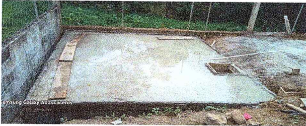
Foto 3: MANTENIMIENTO DE CERCO, MURO Y TAPA DE FOSA
