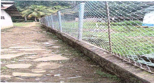
Foto 5: CAMBIO DE MALLA
