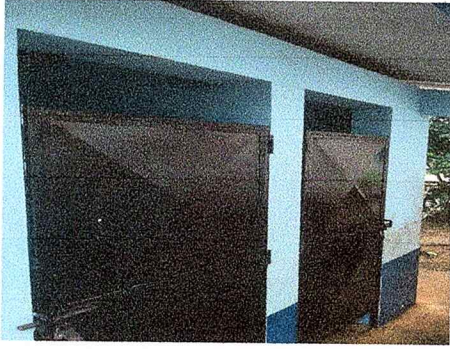
Foto 1: MANTENIMIENTO DE BAÑOS
