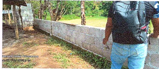
Foto 6: MEJORAMIENTO DE BASE PARA MALLA
