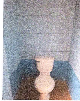
Foto 2: MANTENIMIENTO DE SANITARIOS
